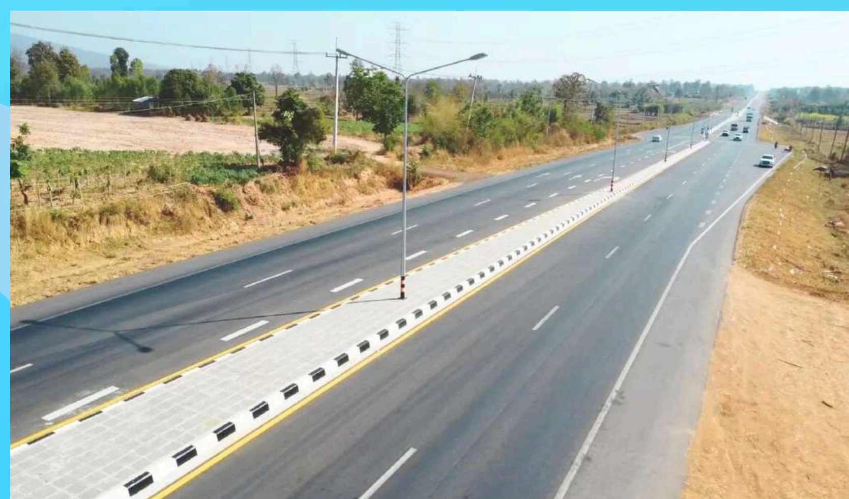
ตัวอย่างการเพิ่มช่องจราจรและขยายไหล่ทางให้ได้มาตรฐาน
