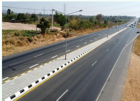
ตัวอย่างการเพิ่มช่องจราจรและขยายไหล่ทางให้ได้มาตรฐาน
